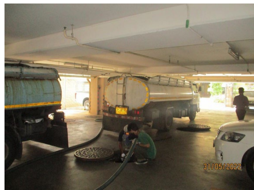
การสูบล้างและทำความสะอาดบ่อบำบัด ภาพที่ 2.2-5 (ต่อ) ระบบบำบัดน้ำเสียและการบำรุงรักษา
